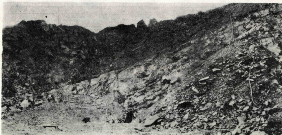
Foto 1. — Bočná stena v kameňolome Šance situovaná v smere pohybu starého zosuvu. Dobře viditeľná tmavšia zosúvajúca sa časť horninového masívu porušená už starým svahovým pohybom.
